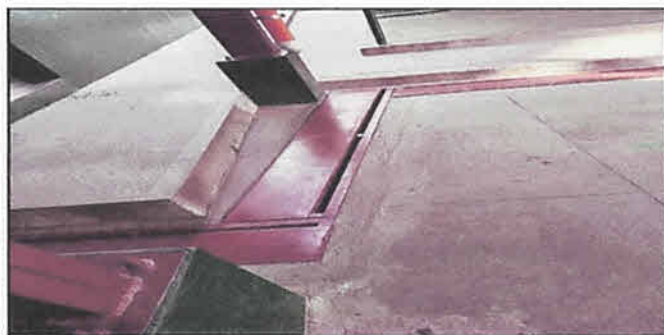
Mantenimiento a rejilla de alcantarillado
