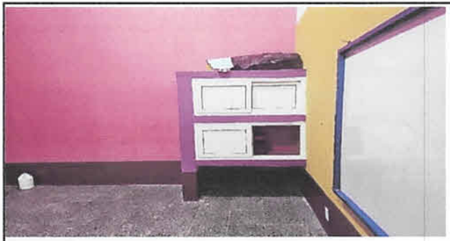
Fabricación de librería de concreto, puertas de pvc.
