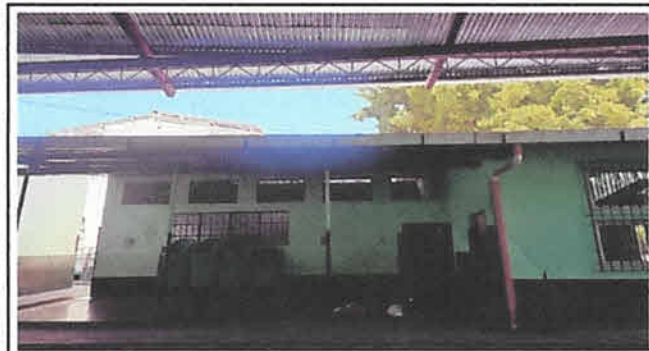
Sustitución de Canal y bajadas para agua pluvial.
