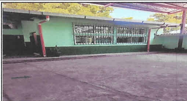
Mantenimiento, lijado y pintura a balcones.
